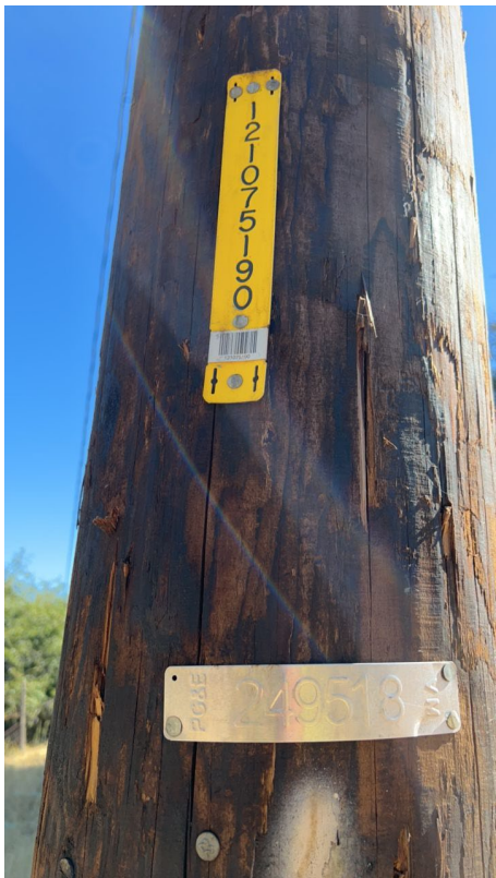
Item3GImg1: Pole ID
