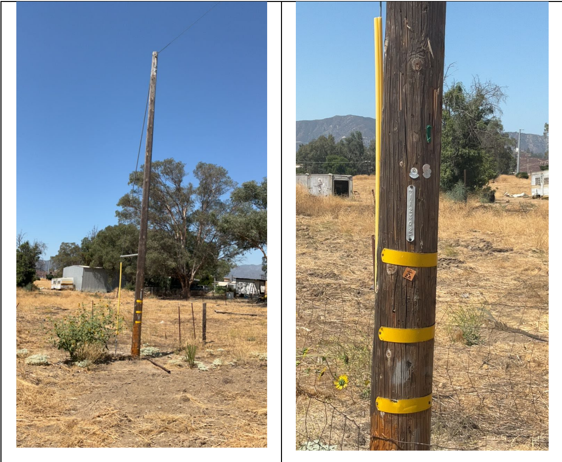
Item1GImg1: Overall Pole Item1GImg2: Pole ID
