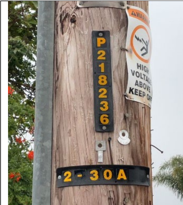
Item1GImg1: Pole ID
