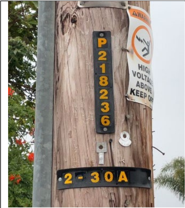
Item1GImg1: Pole ID
