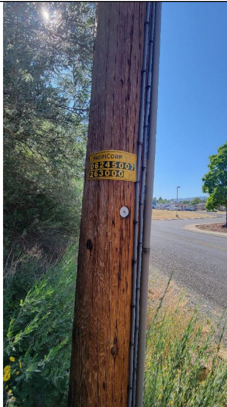
Item2GImg2: Pole ID.
