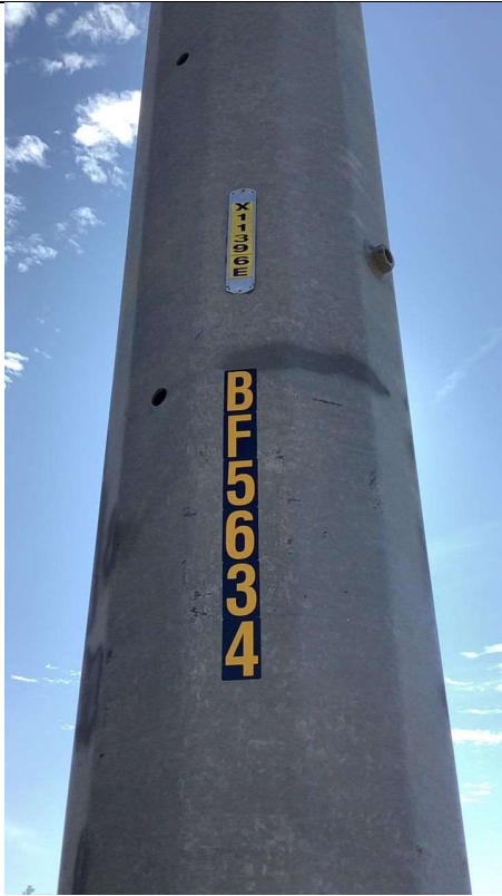
Item5GImg1: Pole X11396E
