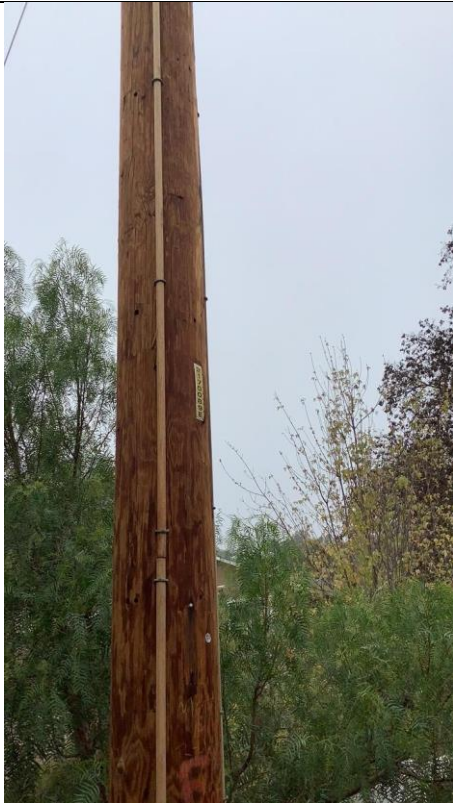
Item4GImg1: Pole 2170089E
