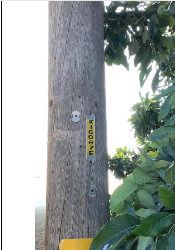
Item1Gimg1: Pole X16067E
