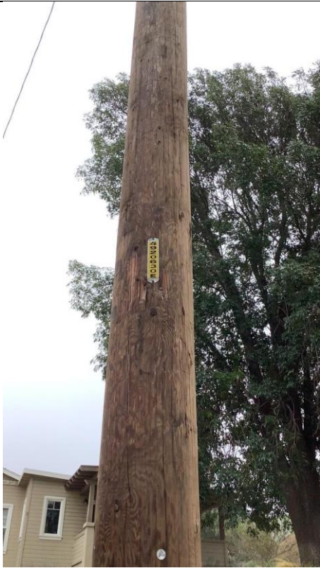
Item3GImg1: Pole 4920630E
