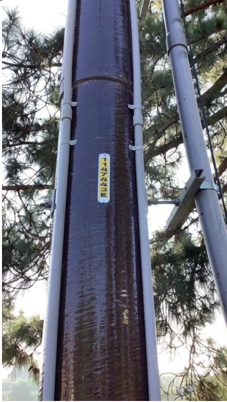
Item2Gimg1: Pole 1147443E
