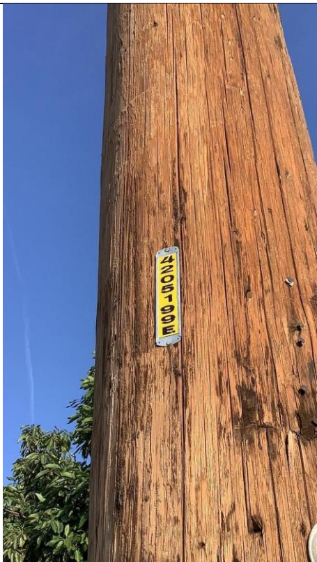
Item1Gimg1: Pole 4205199E
