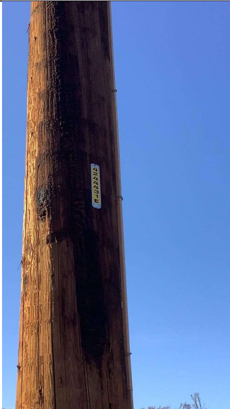
Item2Gimg1: Pole 4244431E
