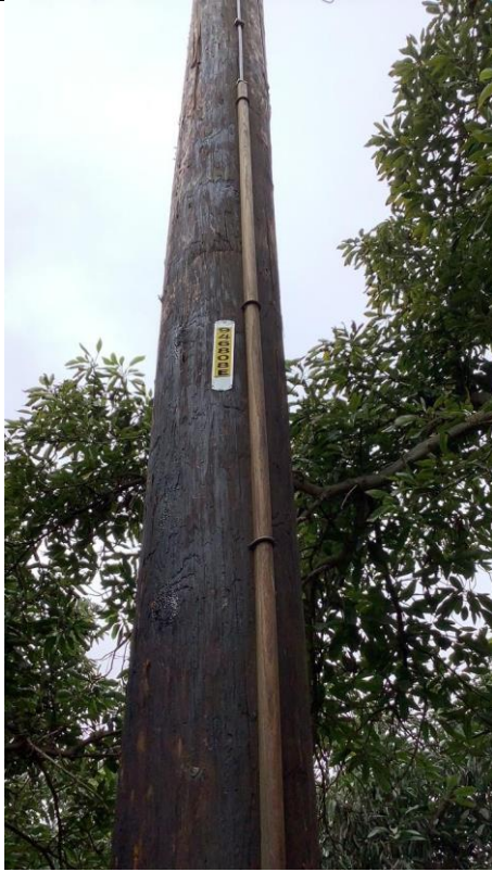
Item3GImg1: Pole 946808E
