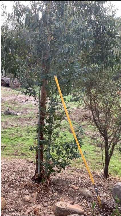
Item1GW1img1: Loose guy wire
