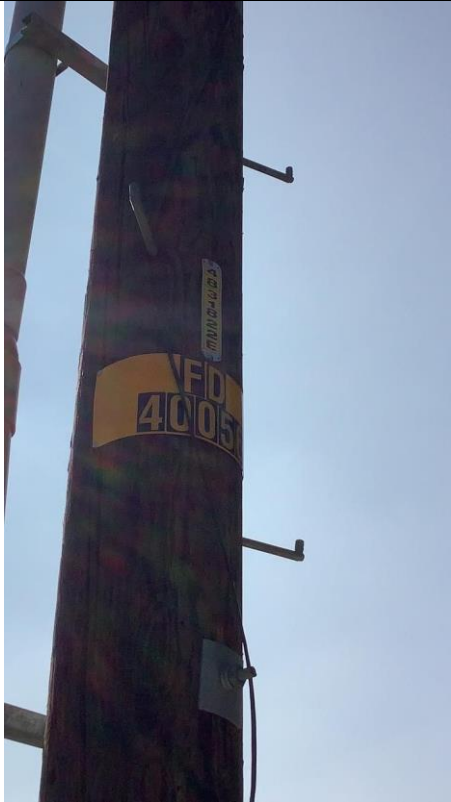
Item3GImg1: Pole 4831822E
