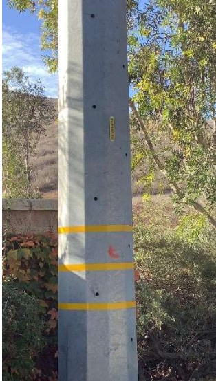
Item1GImg1: Pole 4194272E
