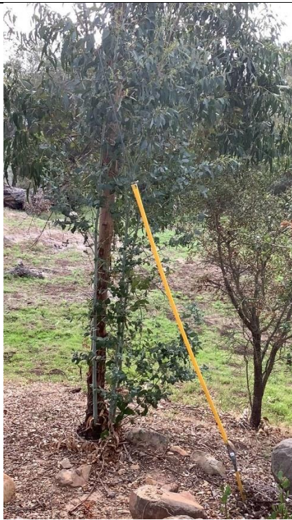
Item1GW1Img1: Loose guy wire
