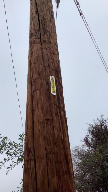
Item2GImg1: Pole 4651151E
