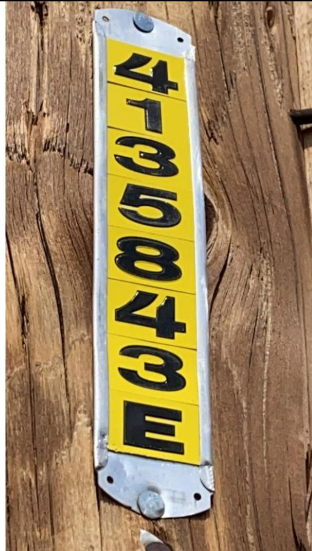
Item8GImg2: Pole ID
