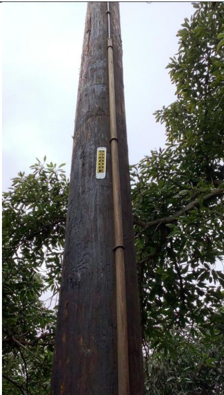
Item3GImg1: Pole 946808E
