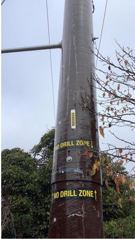
Item1GImg1: Pole 946809E
