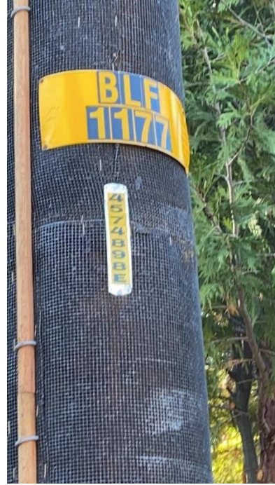
Item12Gimg2: Pole ID
