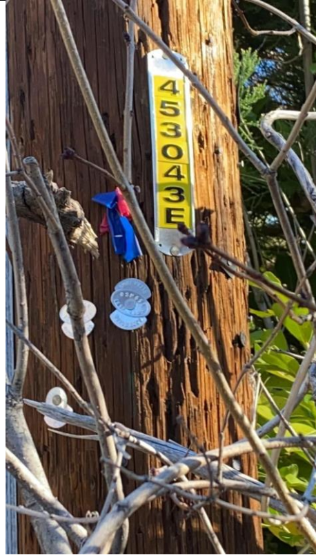
Item5GImg2: Pole ID
