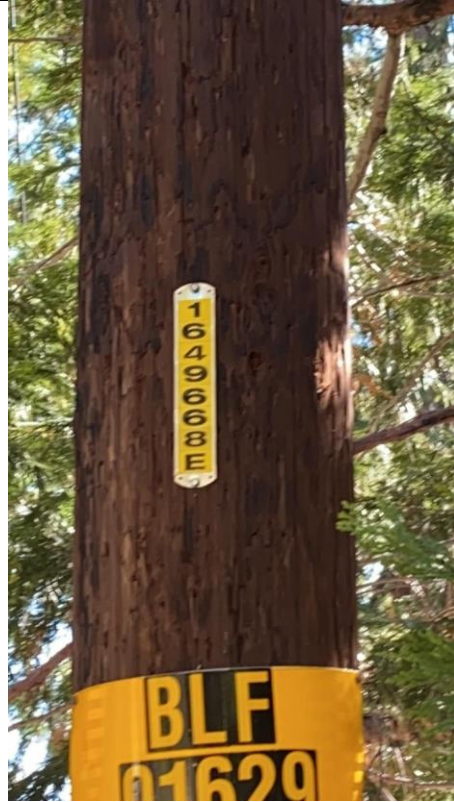
Item9GImg2: Pole ID
