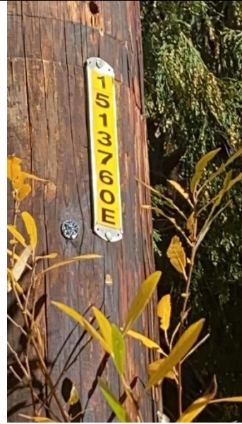
Item19Gimg2: Pole ID
