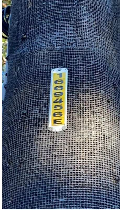
Item10Gimg2: Pole ID
