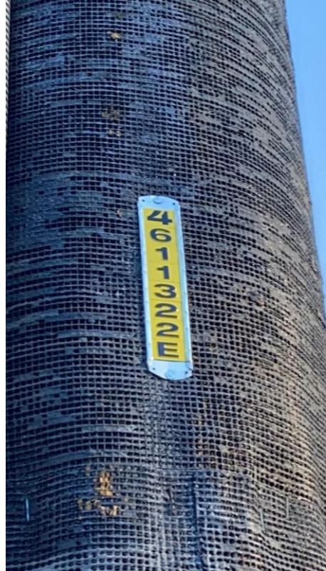
Item4Gimg2: Pole ID
