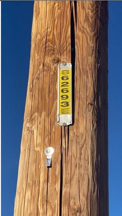
Item4GImg2: Pole ID
