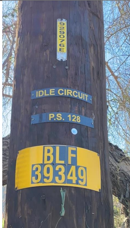
Item7GImg2: Pole ID
