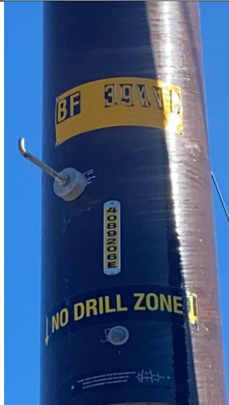
Item14GImg2: Pole ID
