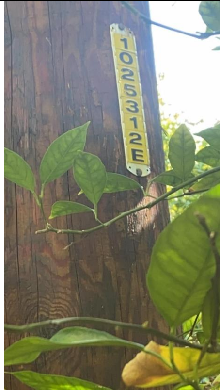
Item15GImg2: Pole ID
