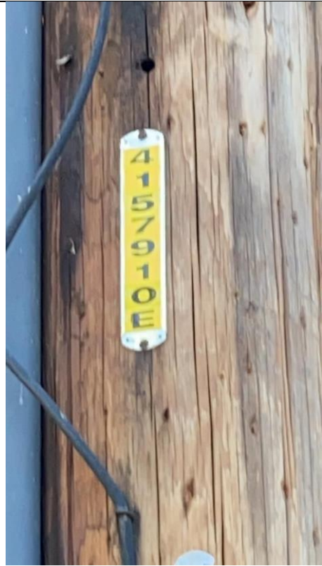
Item12GImg2: Pole ID
