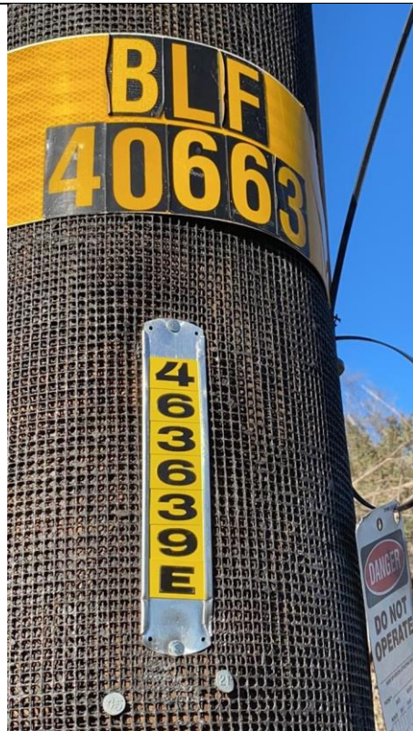
Item1Gimg2: Pole ID
