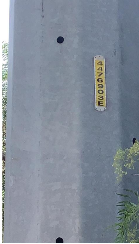
Item10GImg2: Pole ID
