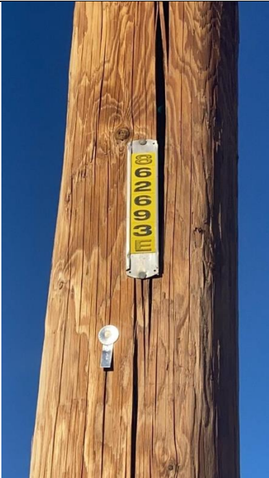
Item4GImg2: Pole ID
