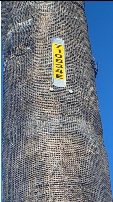
Item3GImg2: Pole ID
