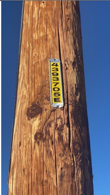
Item8GImg2: Pole ID
