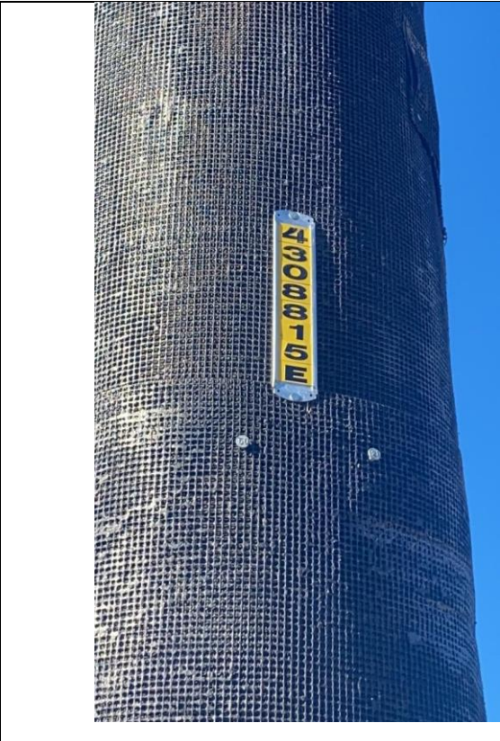
Item10GImg2: Pole ID
