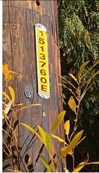
Item19GImg2: Pole ID
