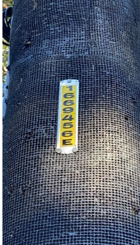
Item10Gimg2: Pole ID
