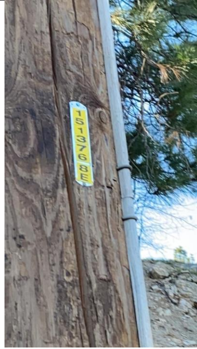
Item17Gimg2: Pole ID
