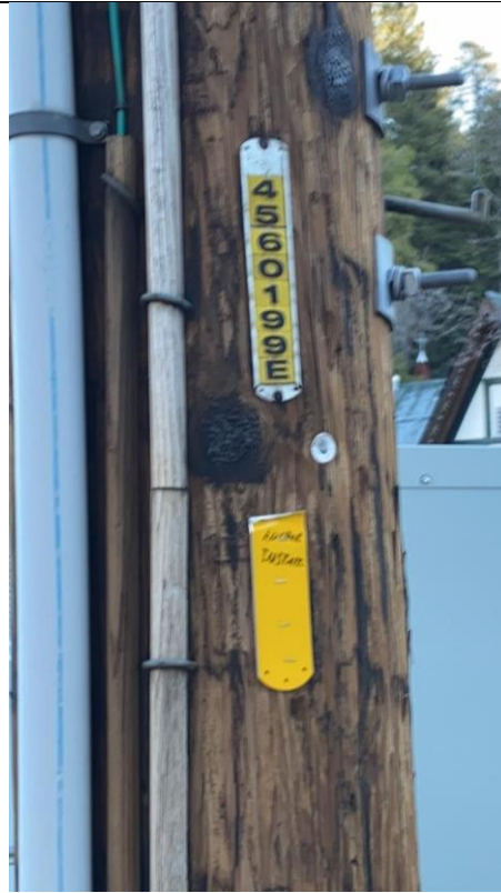
Item2GImg2: Pole ID
