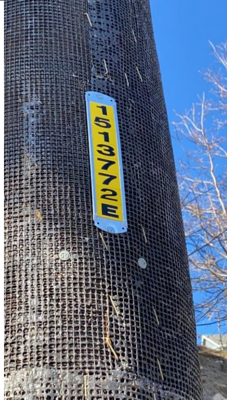
Item15GImg2: Pole ID
