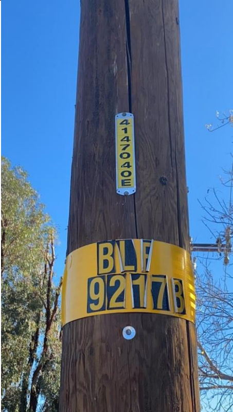
Item9GImg2: Pole ID
