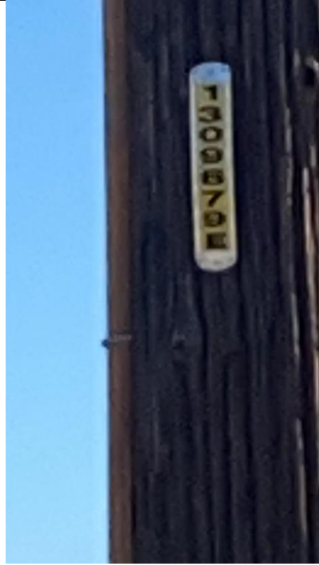
Item6GImg2: Pole ID
