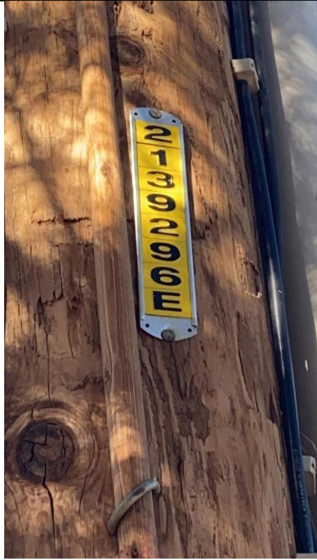
Item10GImg2: Pole ID
