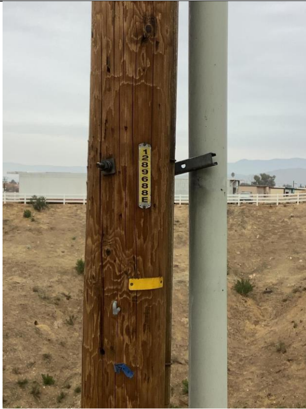
Item4GImg1: Pole ID
