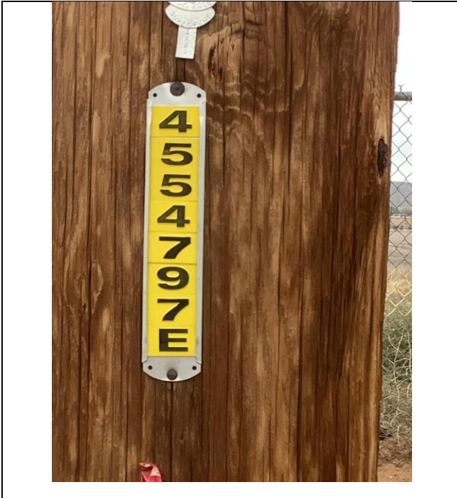
Item7GImg1: Pole ID
