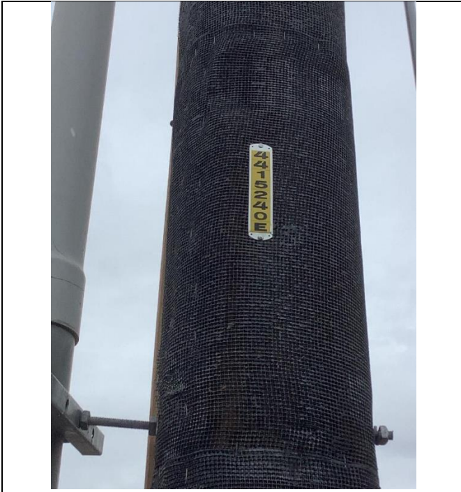
Item16GImg1: Pole ID
