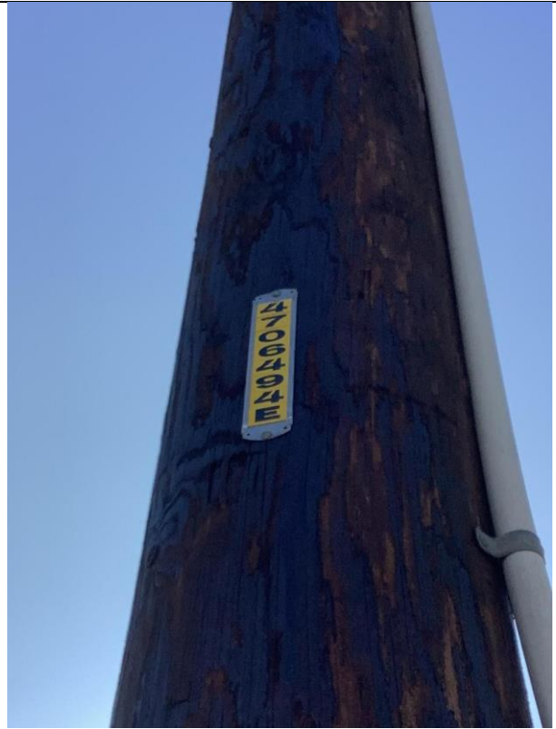
Item4GImg2: Pole ID
