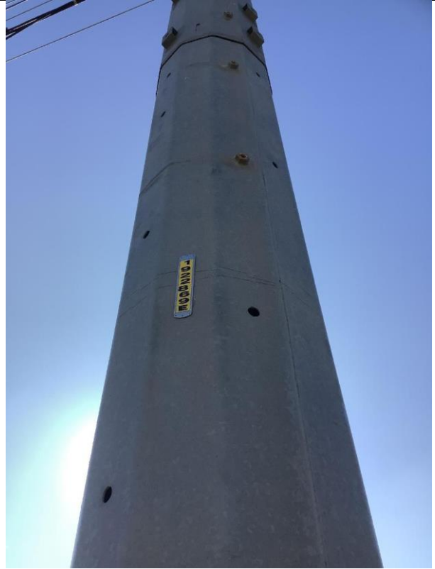
Item3GImg2: Pole ID
