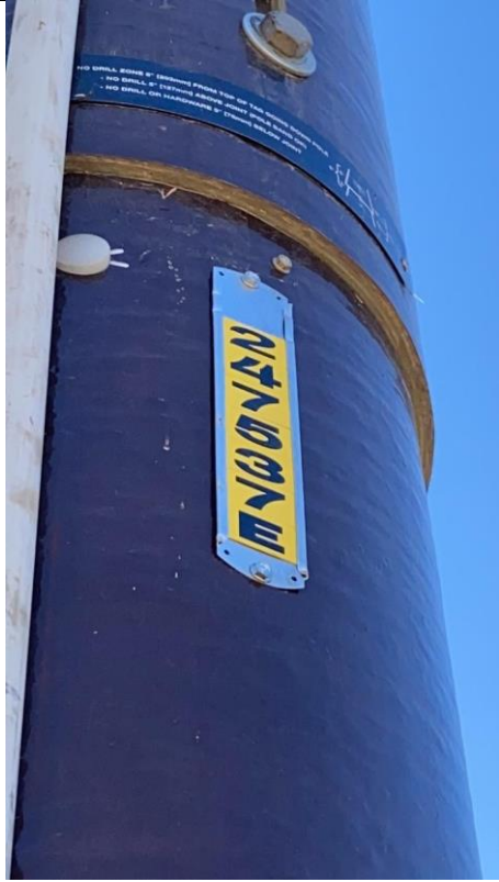
Item5Gimg2: Pole ID
