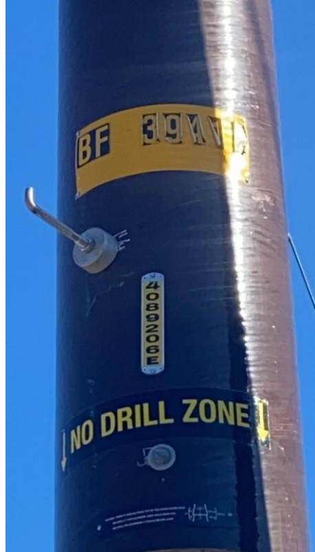
Item14GImg2: Pole ID
