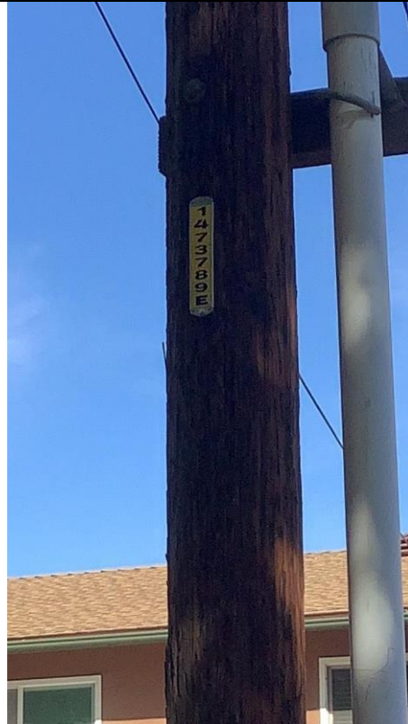
Item7GImg2: Pole ID
