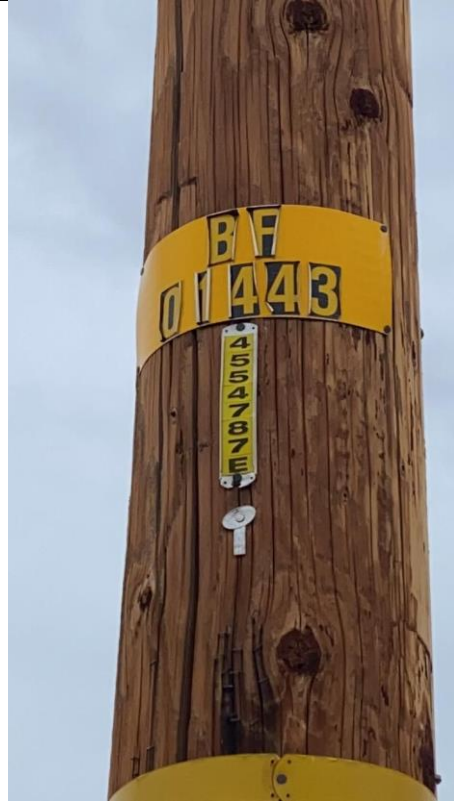
Item12GImg2: Pole ID
