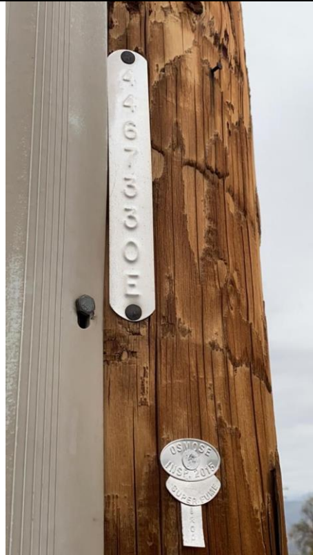
Item3GImg2: Pole ID
