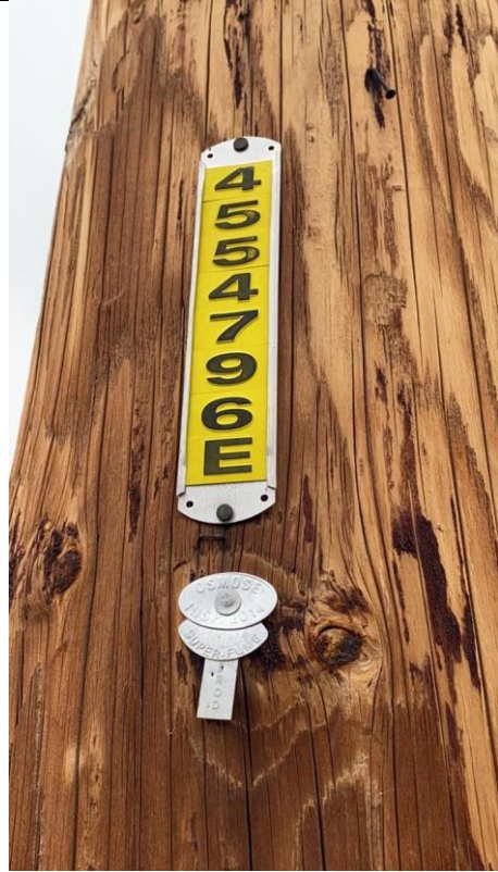
Item7GImg2: Pole ID
