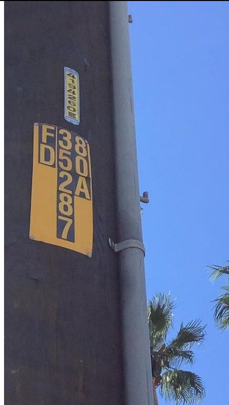
Item5GImg2: Pole ID
