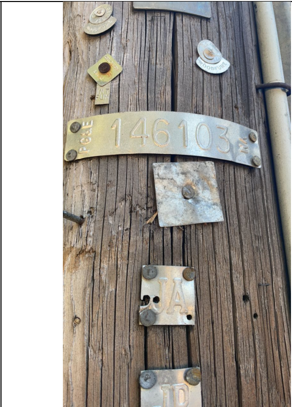
Item1Gimg2: Pole ID.
